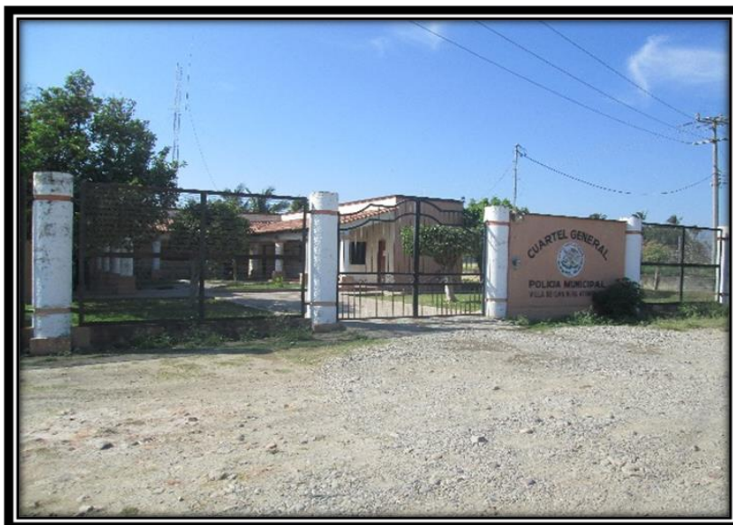
Foto 18.- Cuartel de policía y cárcel municipal
